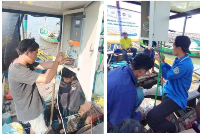
Gambar 3. Pemasangan Inverter dan Baterai di Kompartemen Kapal.
