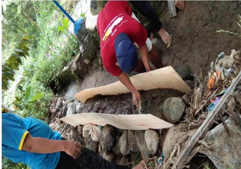
Gambar 5. Perbaikan Saluran Irigasi
