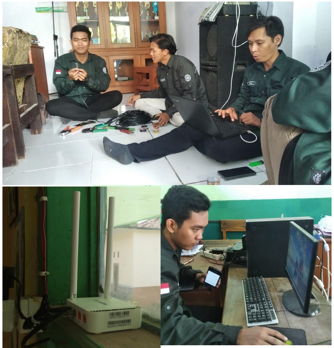
Gambar 4. Pemasangan perangkat di Madrasah Ibtidaiyah Al-Azhar
