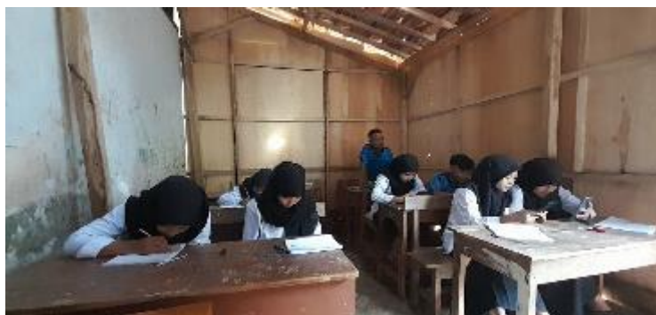
Gambar 2. Kondisi Salah Satu Ruang Kelas SMPN 3 Pakuniran
