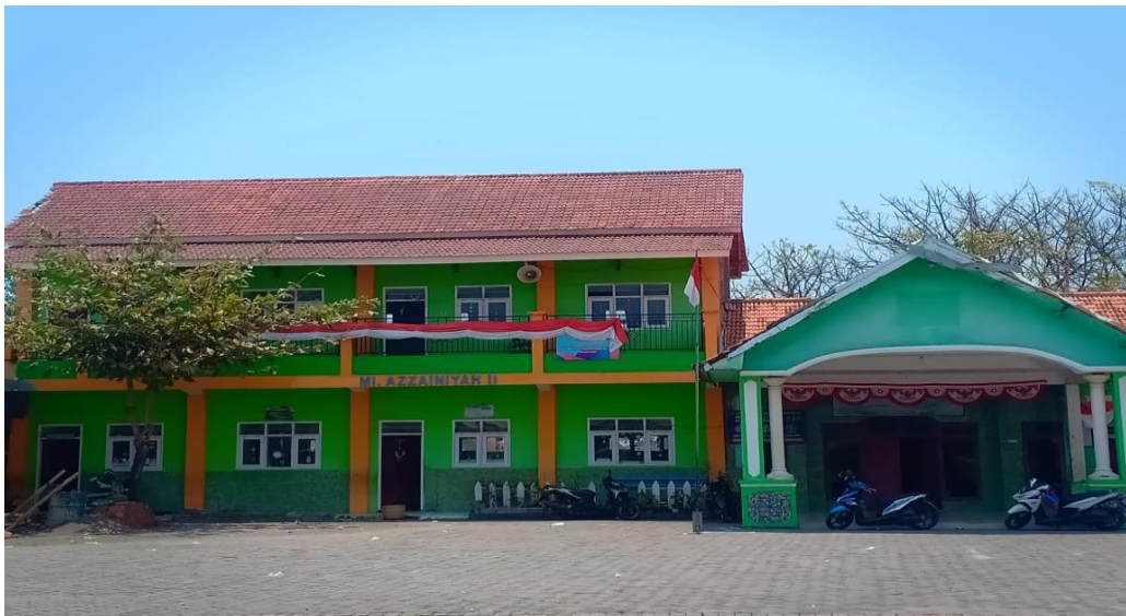
Gambar 1. Gedung Sekolah MI Azzainiyah II
