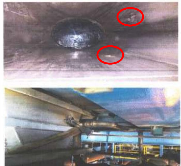
Gambar 4.1. Pemasangan seal air pada discharge coal feeder
